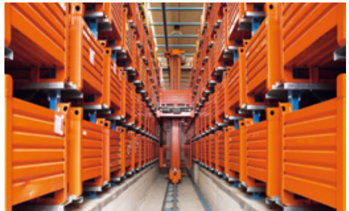
Automatización Fija Completa: Almacenamiento Automatizado y Sistema de Recuperación (AA/SR), clasificación automatizada
